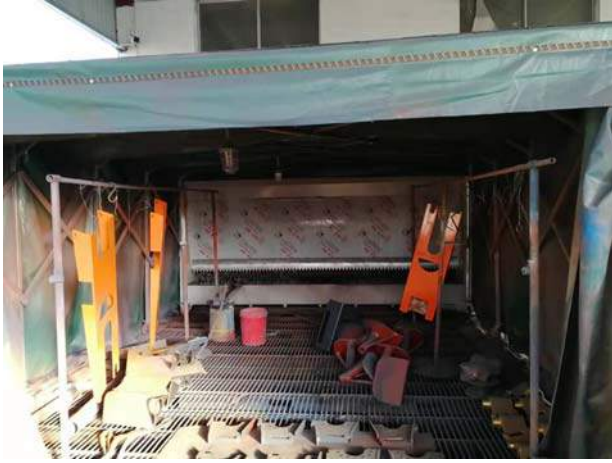
设置水帘+过滤棉+光氧化催化+活性炭吸附处理设施处理喷漆废气
