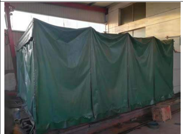
喷漆房内喷漆区域为可移动式伸缩结构，进行封闭处理，加强喷漆废气收集
